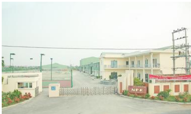
Hình ảnh nhà máy sản xuất NPK
